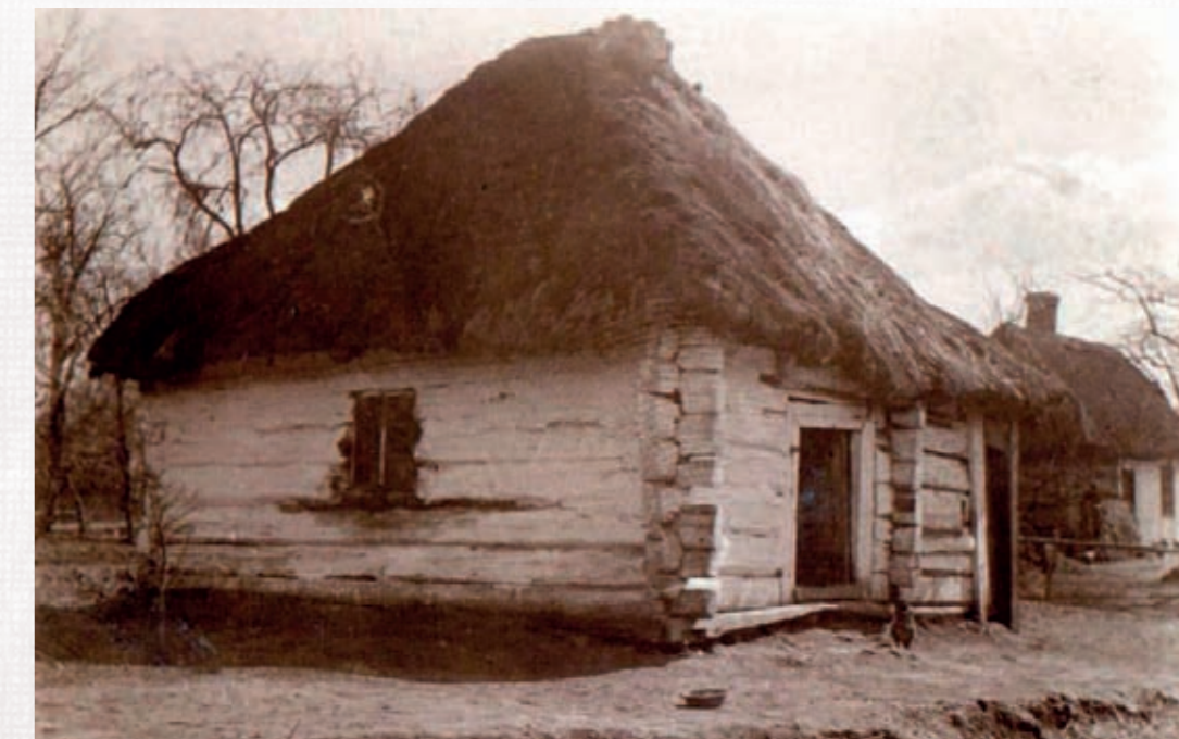
Napis na odwrocie fotografii: chata w Przybysławicach / przeszło 100-letnia / kurna / w planie czworokąta / 1927, fot. nieznaną, zb. spec. MWL
