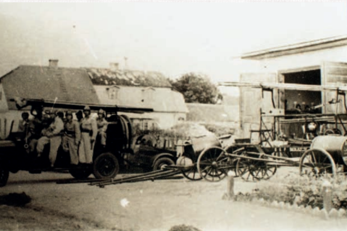
Drużyna strażacka i sprzęt pożarowy OSP w Siedliszczu. W tle domy Libhaberów i Jaworskich, fot. 1942 r., arch. MWL.
