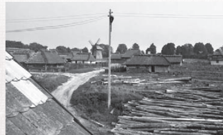
Budowa wsi Wyżyna Lubelska, 1977-1978, arch. MWL.
