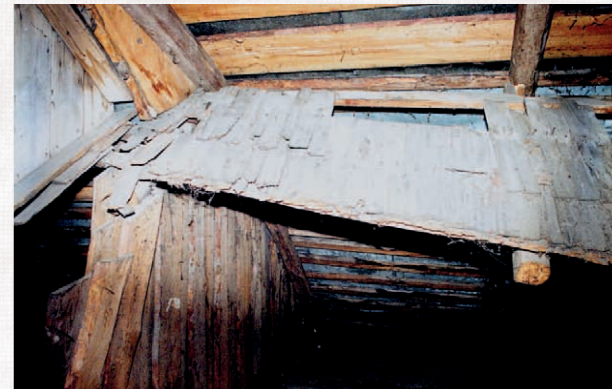
Originalny gont z 1924 r. zachowany na strychu domu Hersza Libhabera w Siedliszczu, pod dachem z blachy stalowej ocynkowanej. Budynek ten odwzorowano w Miasteczku, 2005 r.
