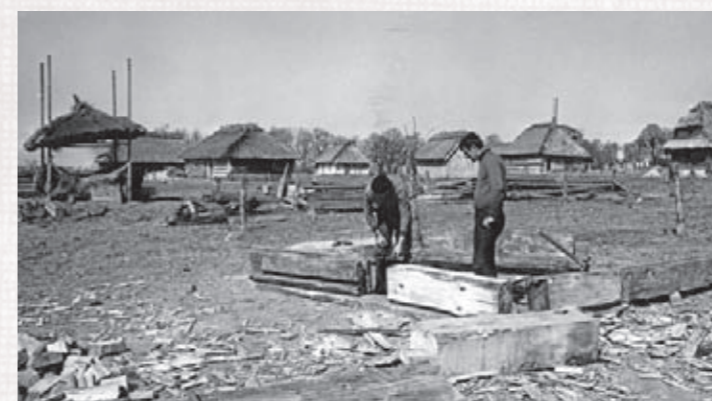
Budowa wsi Wyżyna Lubelska, 1977-1978, arch. MWL.
