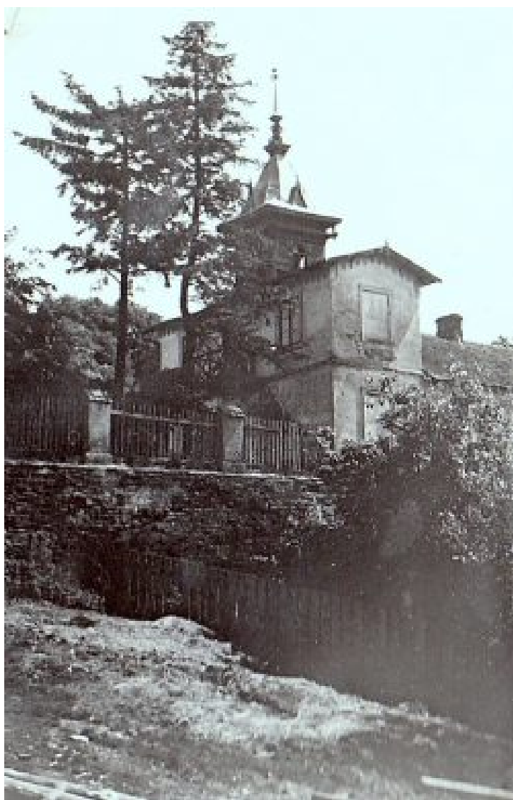
Raz jeszcze oficyna w Woli Żółkiewskiej. Widok drogi prowadzącej do budynków gospodarczych w majątku - podjechali jacyś pod mur, zakradli się przez okno, na linach pospuszczali wszystko (święcone), co było ustawione na stole.
